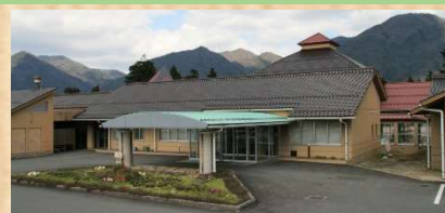
障害者支援施設 くるみ邑美園
